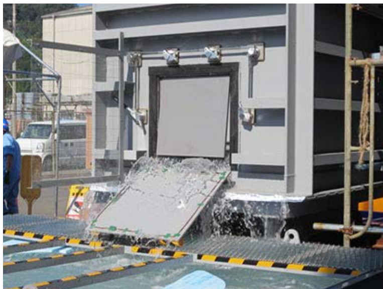
解説図3 通水扉の通水試験の例
