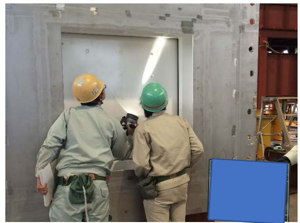
止水パッキンの当り(目視確認)
