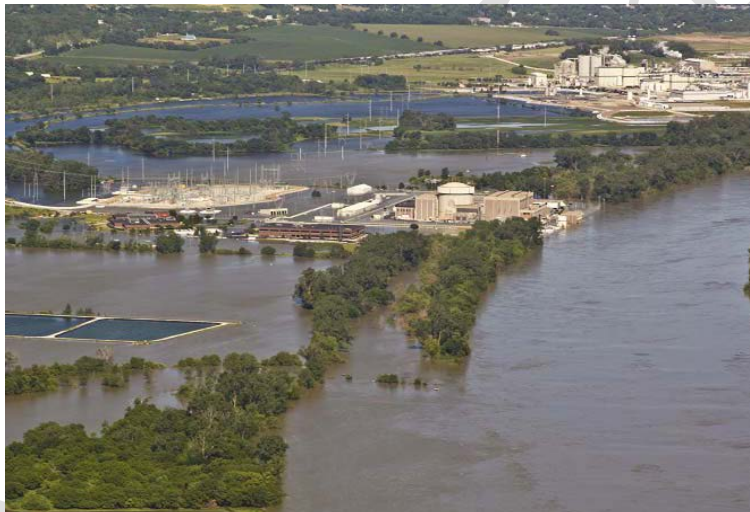
参図 3.1.1-1 洪水時のフォートカルホーン原子力発電所（その1） (1)
