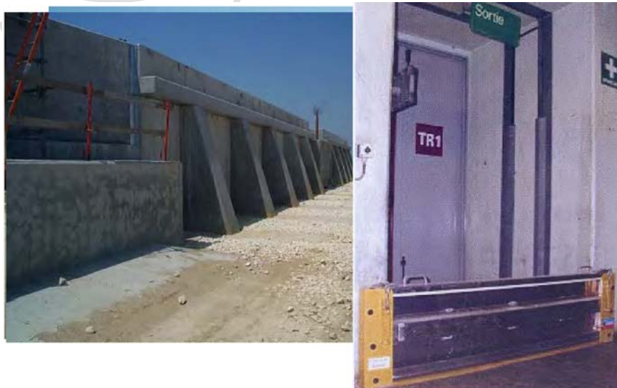
参図 3.2.1-2 対策事例：堤防／壁の嵩上げ，拡張，補強（各サイト共通） (8)
