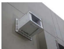
解説図 7 浮体式フラップゲート (壁面設置式) の設置の例
