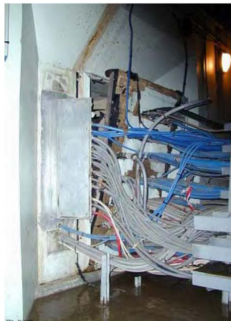
ケーブル貫通口の破損
