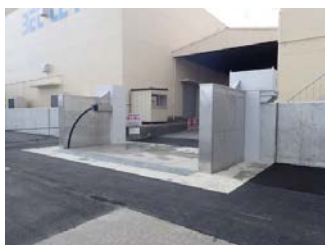
解説図 5 浮体式フラップゲート (平面設置式) の設置の例
