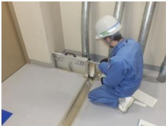
寸法測定（据付位置）
