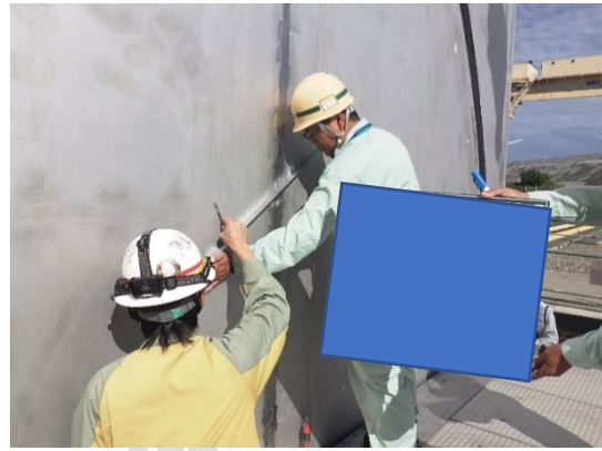
解説図 17 浮体式フラップゲート(平面設置式)の据付検査の実施状況例
