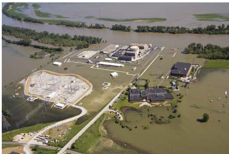
参図 3.1.1-2 洪水時のフォートカルホーン原子力発電所（その2） (1)
