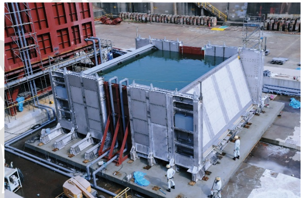
水密検査（湛水確認）
