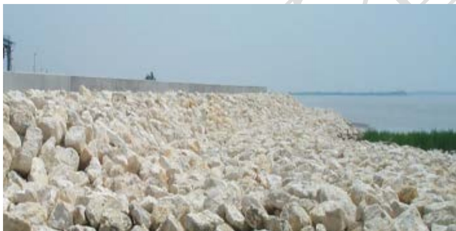
参図 3. 2. 1-4 対策事例：堤防への消波ブロックの設置（ルブレイエ） (7)
