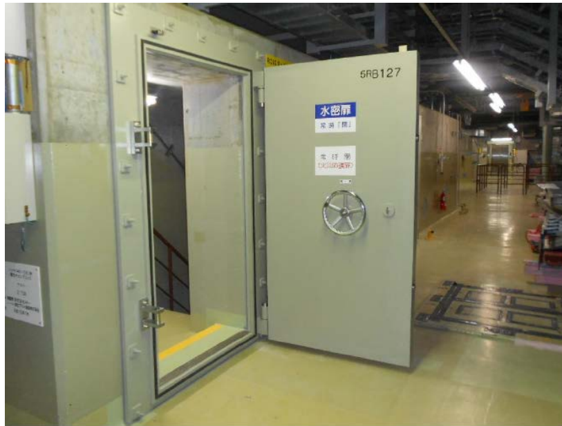
解説図 2 水密扉の設置（既設改造）の例
