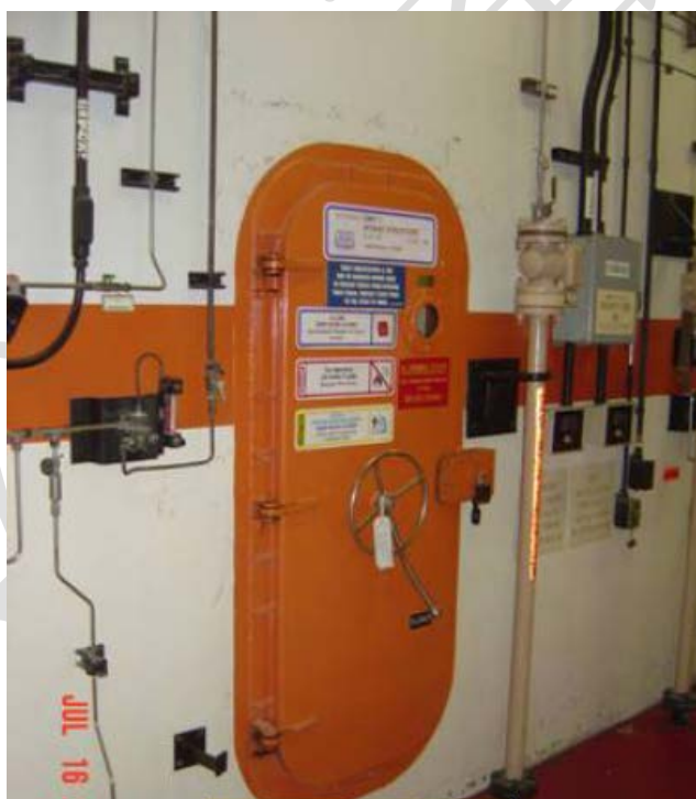
参図 3.1.2-1 ポンプ室入口の水密ドア(3)
