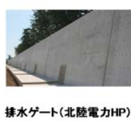
排水ゲート(北陸電力HP)
